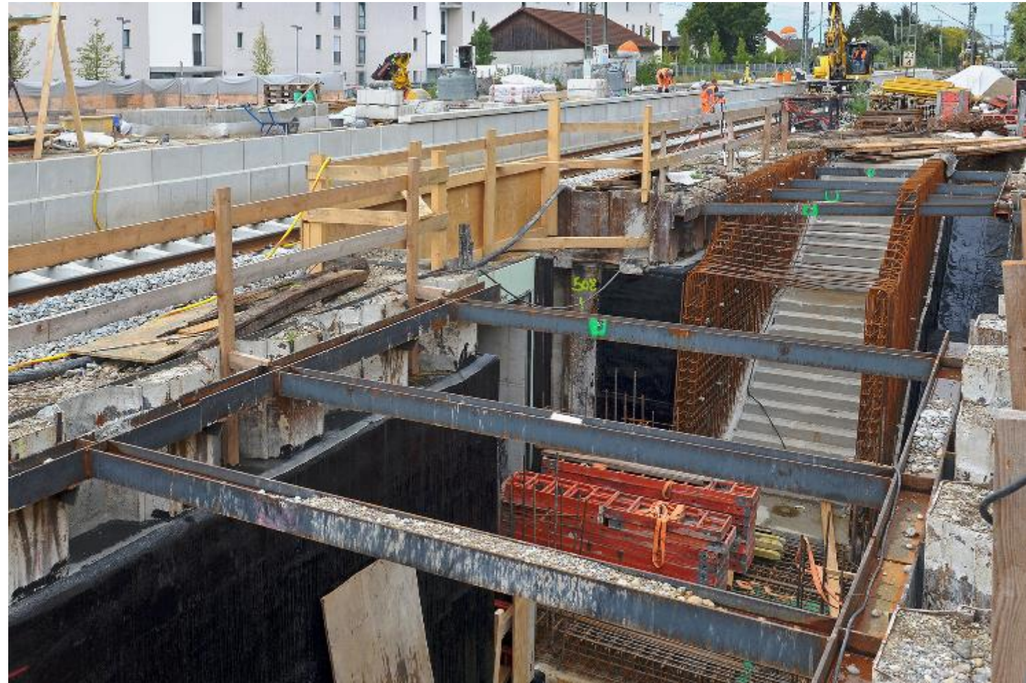
Bauarbeiten in Lohhof; Quelle: www.bahnausbau-muenchen.de , Abruf am 25.04.2019
