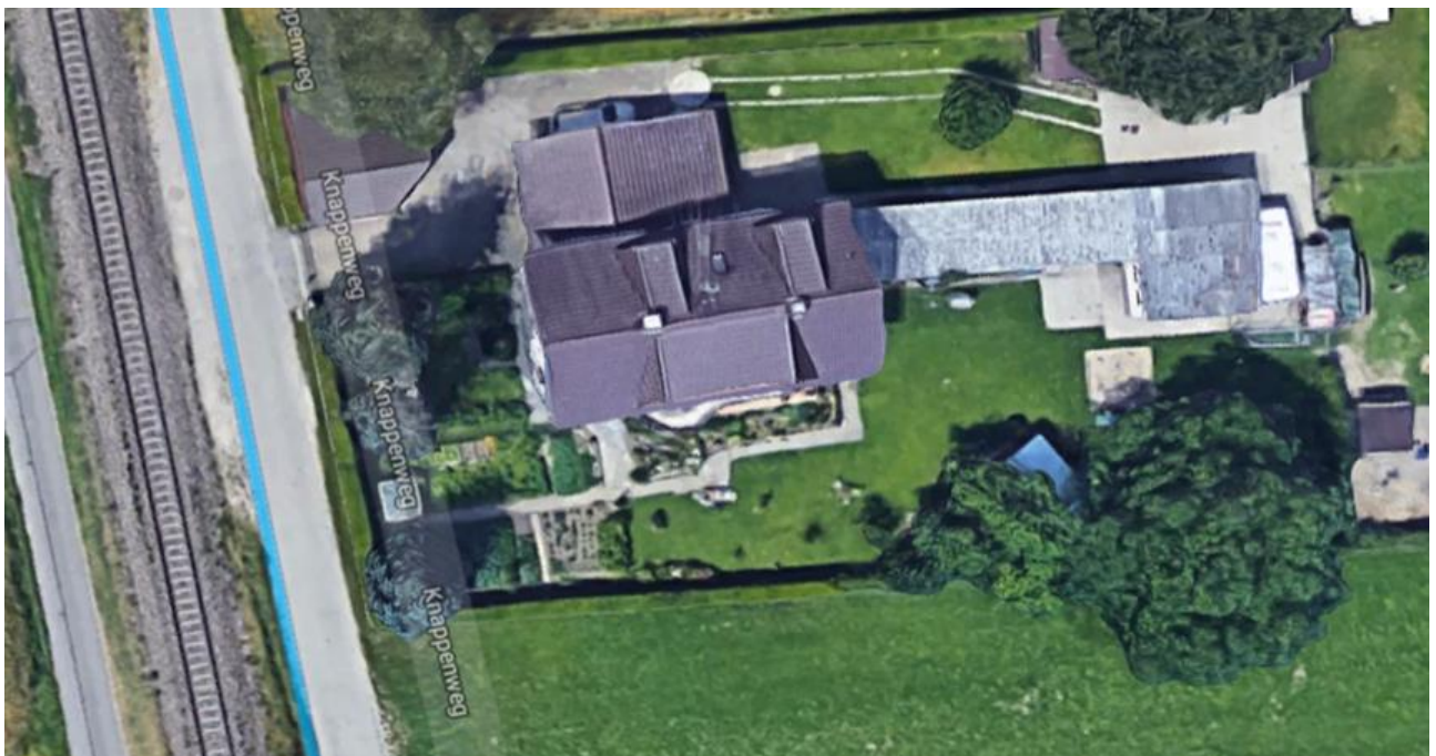
Abbildung 65: Anpassungen der Zuwegungen sind entlang des Knappenwegs erforderlich [Bildquelle: Google Maps]
